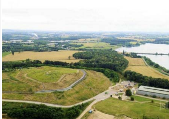
Le centre de stockage des déchets ménagers non recyclables situé à Torcy est géré par Suez Centre-Est (ex-Sita). Il enfouissait 55 000 t de déchets par an. Photo société DRONAPEX
